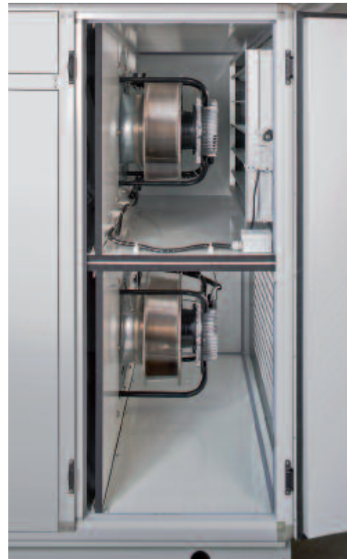
Slika 2. Detalj uređaja: Ventilatori
